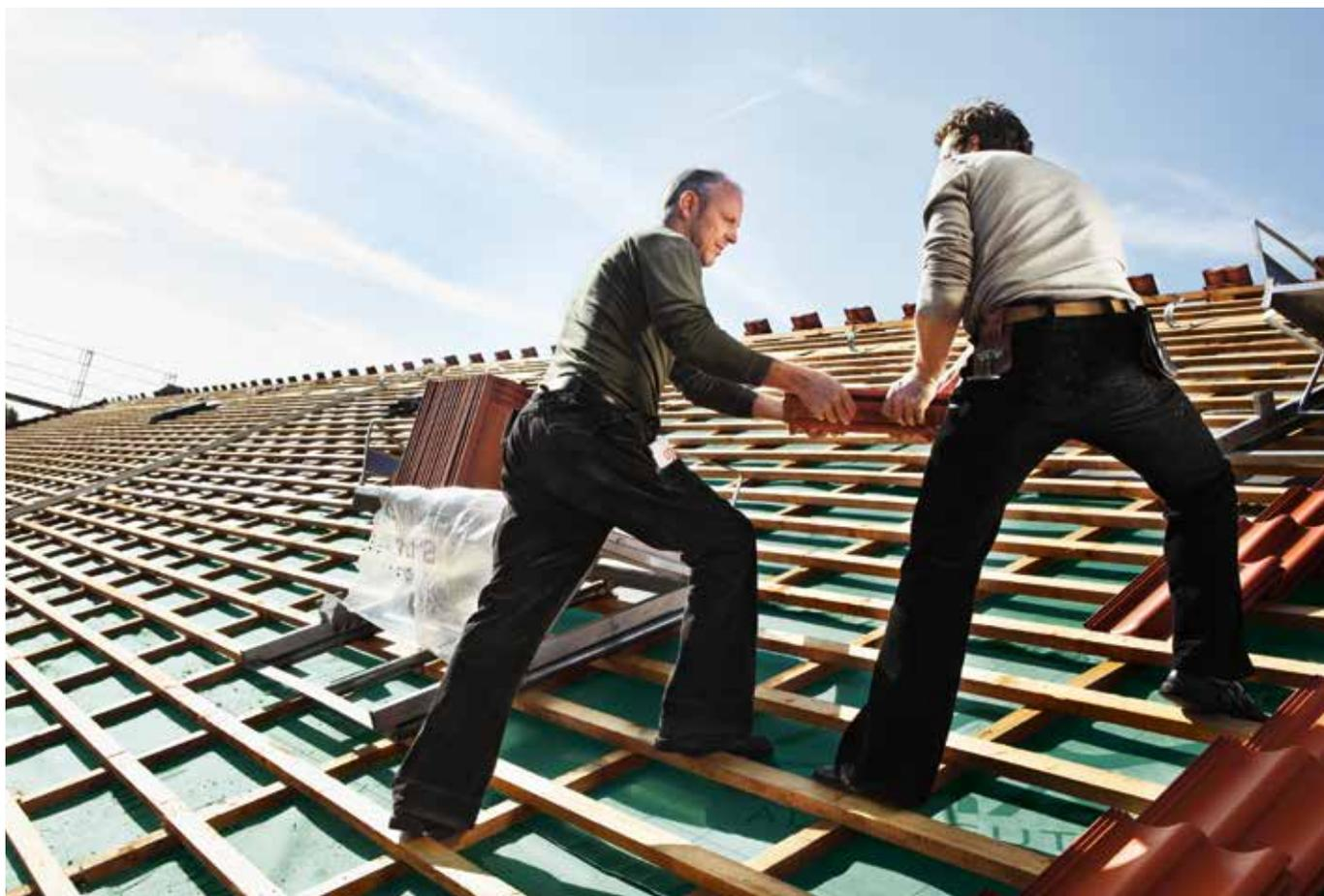
Alle sichtbaren Sparrenköpfe sind gehobelt. Die Untersichtschalung für die Trauf- und Giebelüberstände sowie das Stellbrett erstellen wir aus gehobelten Nut- und Feder-Brettern. Wir empfehlen, die Außenhölzer vor Anbringung des Außenputzes gegen Witterungseinflüsse zu schützen. Auf Wunsch erhalten Sie die Außenhölzer in verschiedenen Farben und Lasuren.
