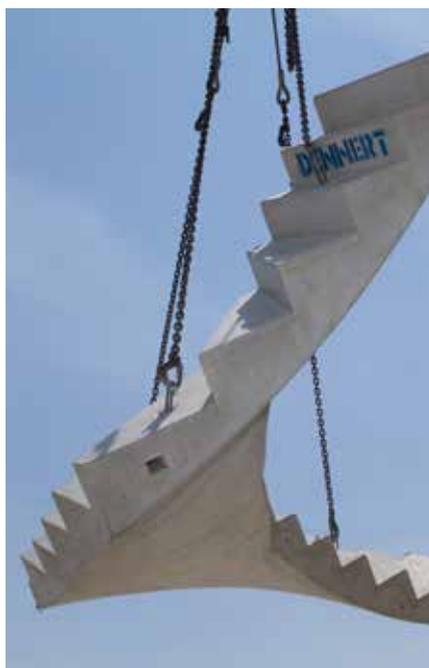
Stahlbeton-Fertigterrasse mit tapezierfertiger Untersicht.
