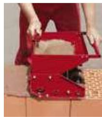
Beim VD-System wird der Mörtel mittels Mörtelschlitten vollflächig und gleichmäßig aufgetragen.
